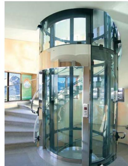
Для подключения лифта не требуется специальной электропроводки. Он питается от обычной бытовой сети напряжением 220В, потребляя не более 2,5 кВт, что сопоставимо с мощностью электрического чайника.
